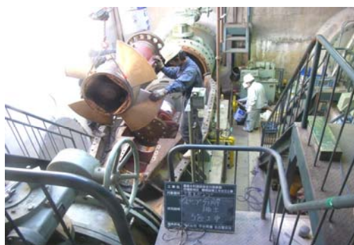
(ポンプ分解・搬出)
