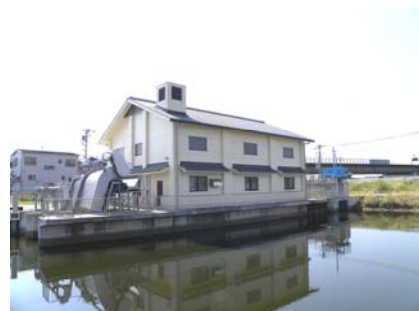
(小切戸排水機場)
