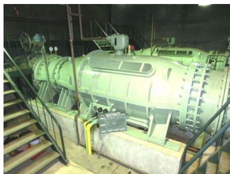
(ポンプ整備・据付完了)
