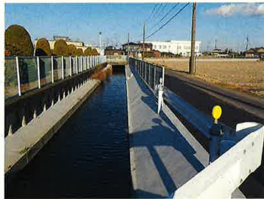
神守地域の排水路（津島市）
