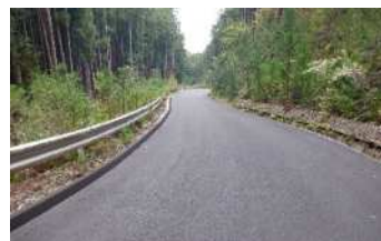
整備した林道
