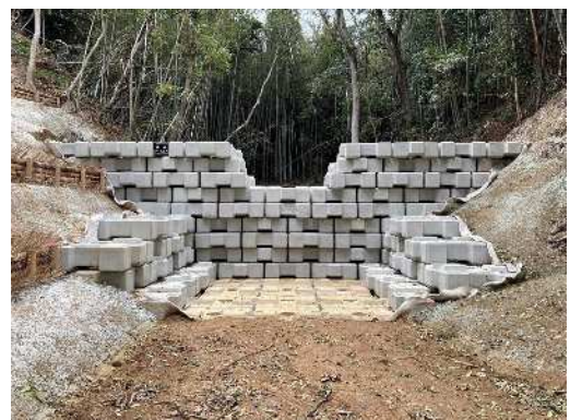
【山地災害から守る治山施設】
