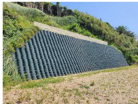
【治山施設（土留工）】
