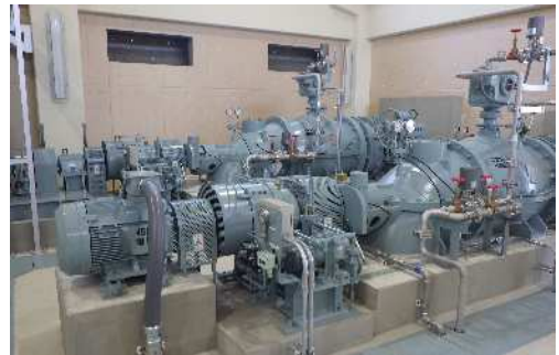
【高師第一排水機場】
