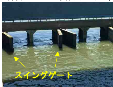
図 2.4-6 高浜川水門の操作方法
