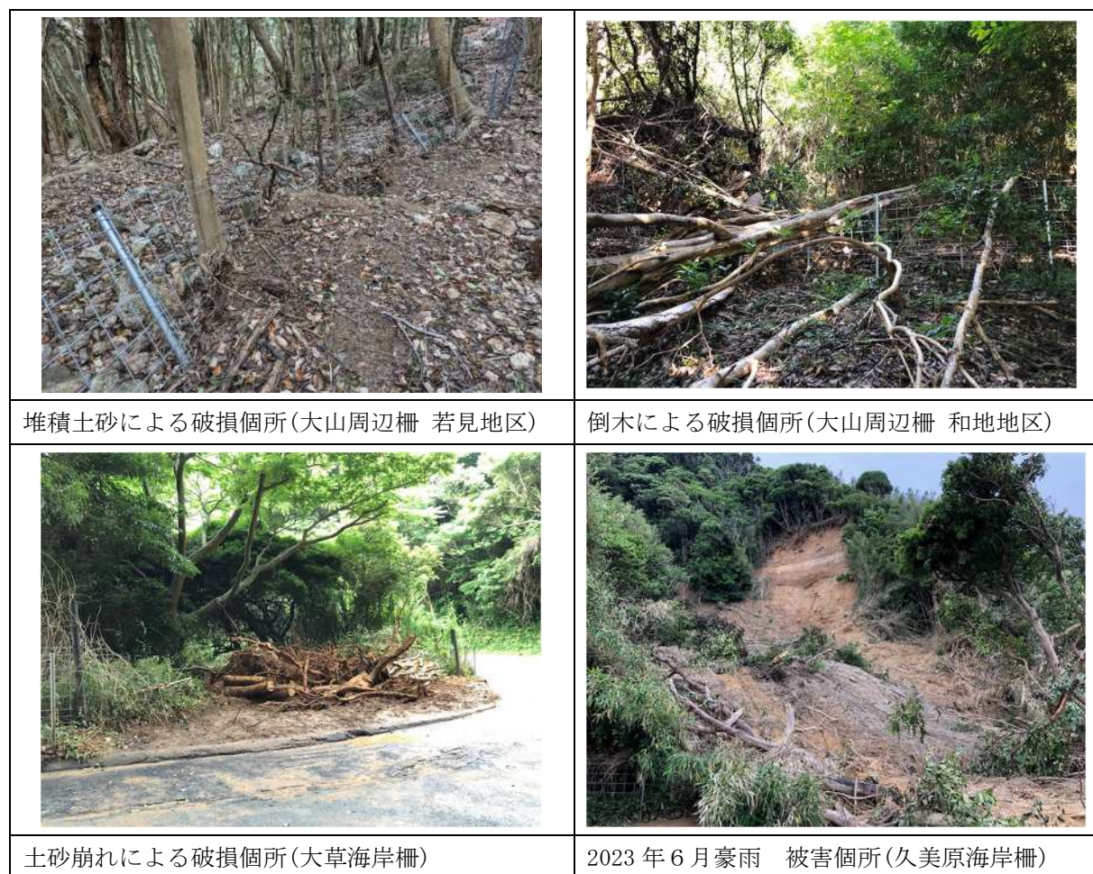
図3 主な破損状況 (写真)
