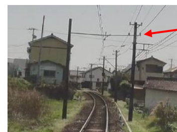
【渥美線】木製電柱のコンクリート化
