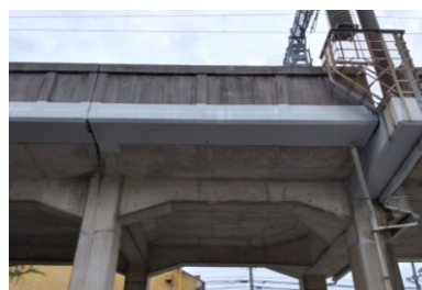
橋梁修繕（剥落防止）
