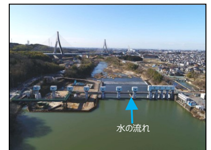
明治用水頭首工地区 土地改良施設突発事故復旧事業
