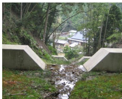
災害から生命・財産を守る治山施設
