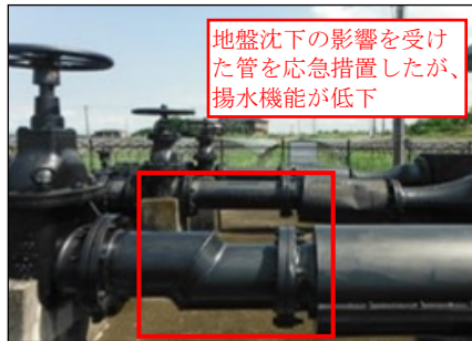
木曾川用水濃尾第二施設改築 (揚水機場の地盤沈下状況)
