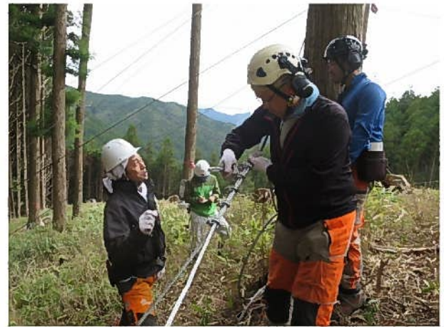
クリップを取って締め直す クリップの設置位置に印をつけておくと ワイヤーが滑った際に視認できる
