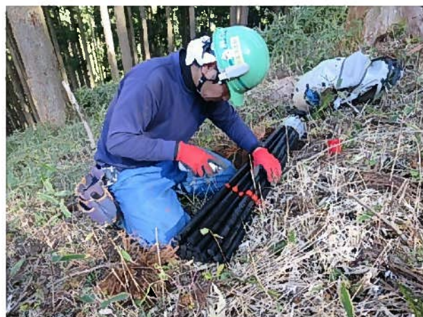
支柱打ち込み位置をラッカーで印付
