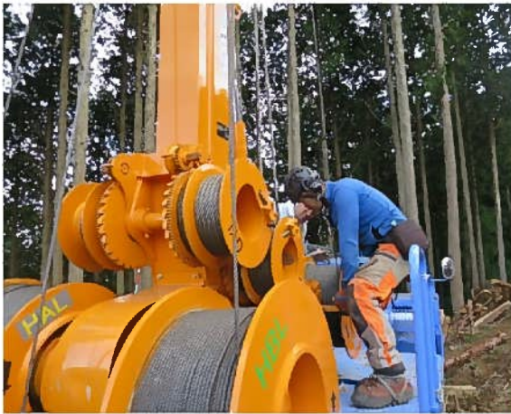
タワーヤードのガイラインを調整
