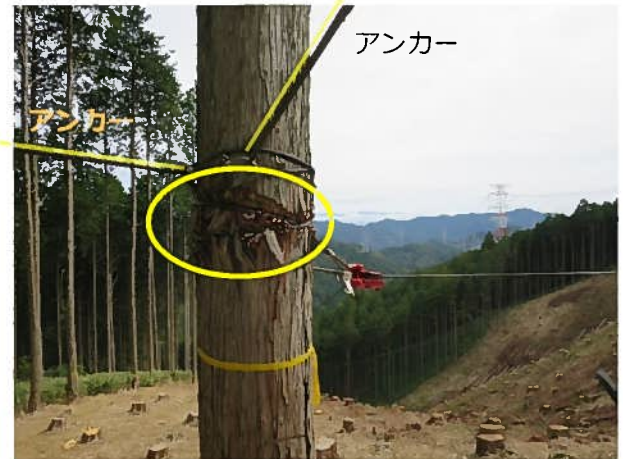
サンド木⑥ 滑車高さ 1.5m 位 角 アンカーは取ってある。DRL の食い込みがひどい
