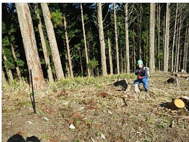
支柱位置決め 支柱間の長さの紐を前の杭にかけ、障害物等も見ながら位置決め。
