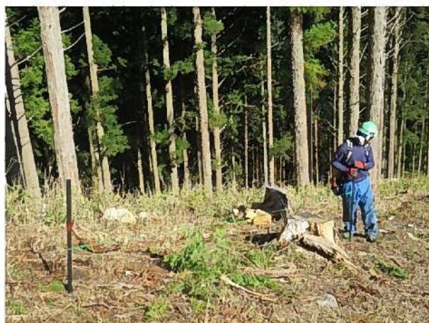
支柱位置決め 支柱間の長さの紐を前の杭にかけ、障害物等も見ながら位置決め。
