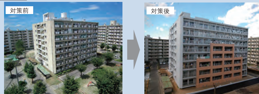
長寿命化改善工事(県営大森向住宅)
