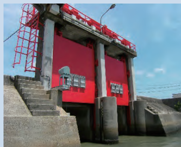
水門等の耐震化及び自動閉鎖化 (西尾海岸 平坂樋門)
