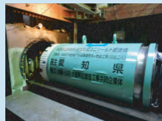
幹線管渠整備 状況 (日光川下流域 下水道)
