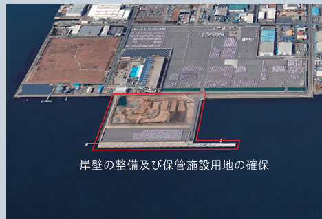
-11m岸壁及びびふ頭用地の造成 (三河港蒲郡地区)
