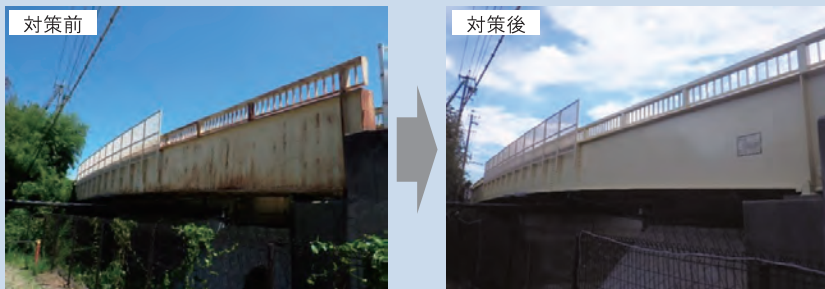
橋梁の修繕工事(県道西中山越戸停車場線 青木橋歩道橋)
