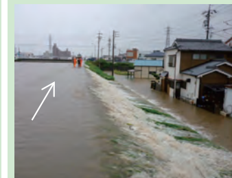
河川の氾濫 (2011年台風15号 八田川(春日井市))
