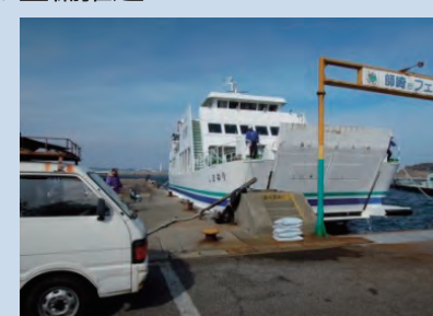
フェリー岸壁の耐震化(篠島漁港)
