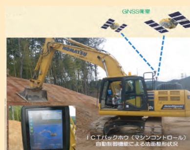
ICTバックホウによる法面整形
