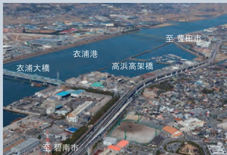
港湾アクセス道路の整備 (国道247号、国道419号)
