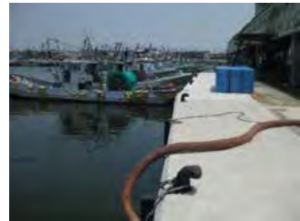
漁港施設の耐震化（大浜漁港岸壁）
