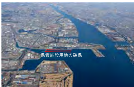
ふ頭用地の造成（衣浦港中央ふ頭西地区）
