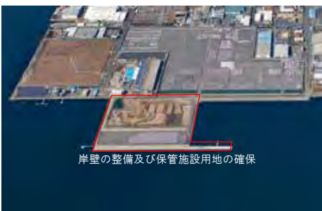
-11m 岸壁及びふ頭用地の造成（三河港蒲郡地区）
