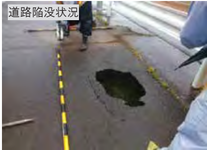
管渠老朽化に伴う道路陥没状況と対策工事（下水道管渠）
