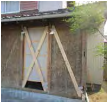
住宅の耐震改修
