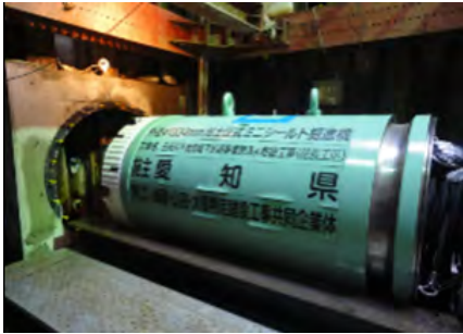
幹線管渠整備状況 (日光川下流流域下水道)
