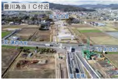
広域幹線道路の整備（名豊道路 蒲郡バイパス）
