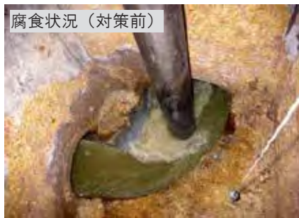
マンホールの腐食状況と対策工事（下水道管渠）
