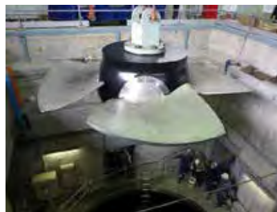
ポンプ分解整備（インペラ） （日光川排水機場 3号ポンプ）
