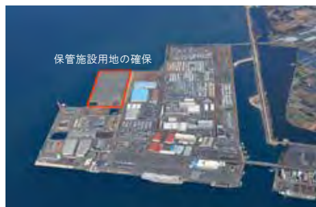
ふ頭用地の造成（三河港神野地区）
