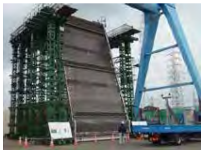
除塵機更新（幅 7.5×高さ約 15m） （日光川排水機場 1号除塵機）
