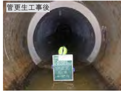
管渠老朽化に伴う道路陥没状況と対策工事（下水道管渠）
