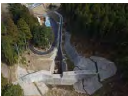
砂防堰堤の整備（戸津呂川第1支川）
