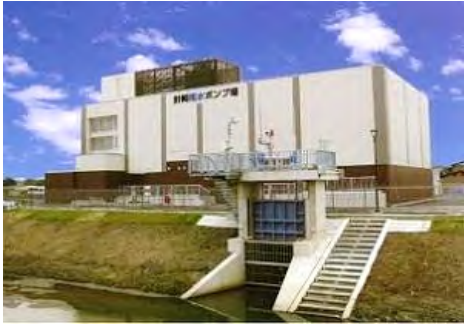
針崎雨水ポンプ場の整備（岡崎市）
