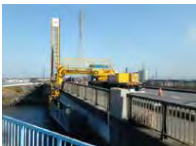
橋梁点検状況
