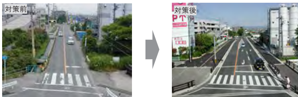
交差点の改良（右折帯設置）による抜本対策（県道小牧春日井線）
