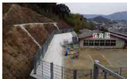
急傾斜地崩壊防止施設の整備（今御堂区域）
