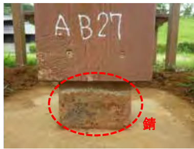
一本鋼製柱の四阿補強工事（東三河ふるさと公園）
