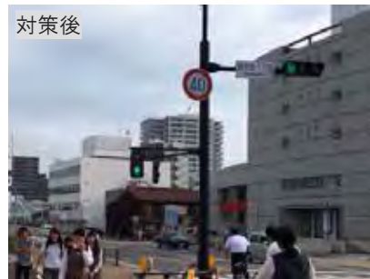
電線共同溝整備による無電柱化（国道 247 号）
