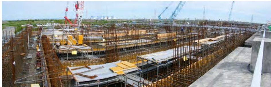
水処理施設増設状況 (矢作川浄化センター)
