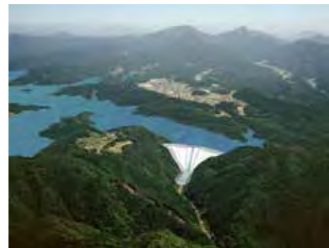
設楽ダム完成予想図 (出典：中部地方整備局設楽ダム工事事務所ホームページ)
