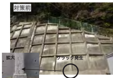
急傾斜地崩壊防止施設の修繕工事（間草区域）
