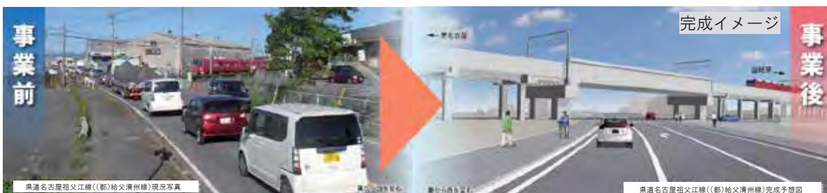
鉄道高架事業の推進例（新清洲駅付近鉄道高架）
