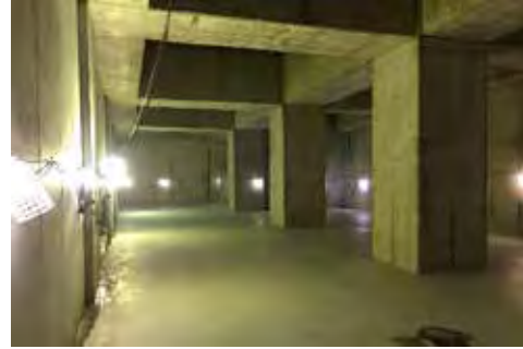
北園通貯留槽の整備（一宮市）
