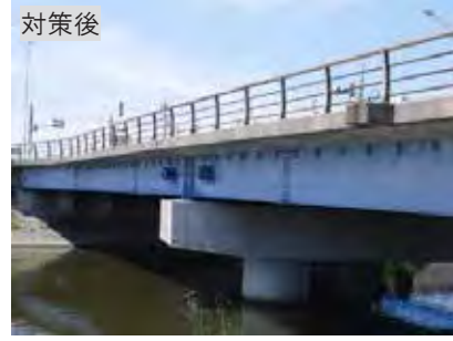
橋梁の耐震補強（県道蟹江飛島線 新善太川橋）
