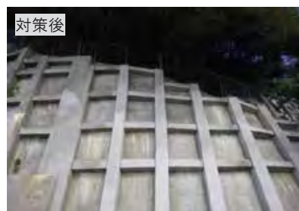
急傾斜地崩壊防止施設の修繕工事（間草区域）
