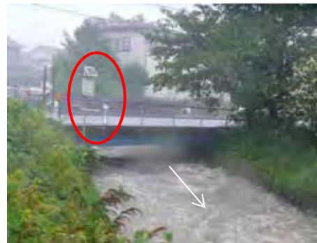
危機管理型水位計の設置事例（天神川）
