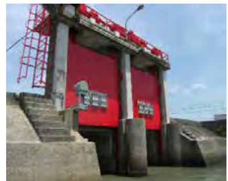
水門等の耐震化及び自動閉鎖化（西尾海岸 平坂樋門）
