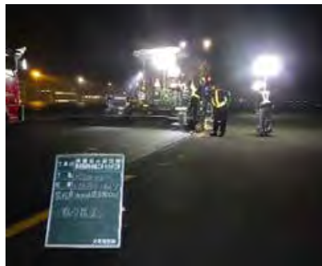
誘導路舗装の修繕
