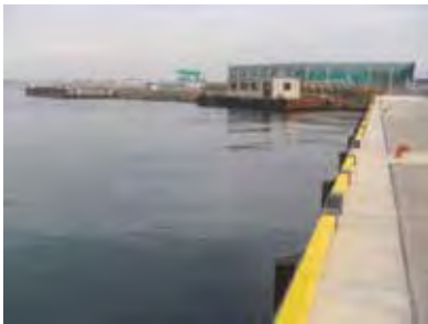
車止め補修 (衣浦港武豊北ふ頭物揚場)
