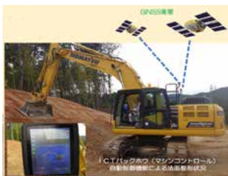
ICT バックホウによる法面整形
