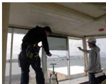
ガラスフィルム飛散防止施工状況
