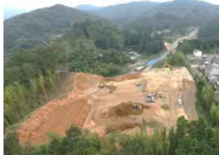
UAV（無人航空機）による現場状況確認
