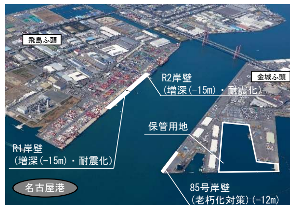
▲名古屋港の耐震岸壁等の整備
