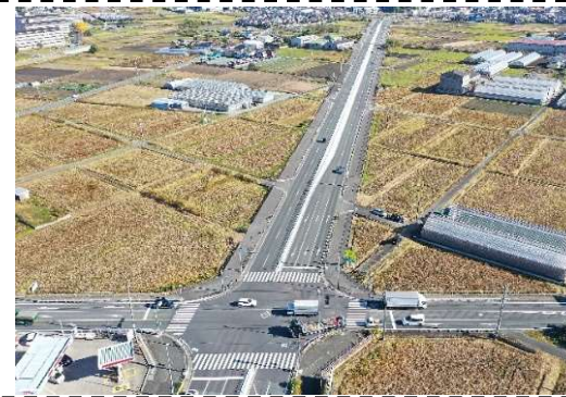
(主)東三河環状線 大崎工区 (豊川市)
