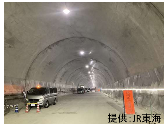
▲リニア中央新幹線 西尾工区本坑掘削工(春日井市) 提供:JR東海
