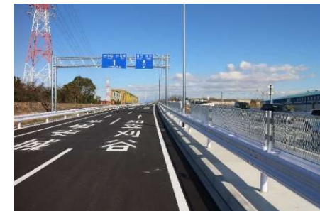
(国)247号 碧南高浜拡幅(碧南市・高浜市)
