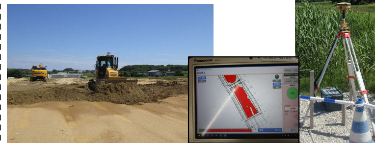
ICT建設機械による施工状況（西知多道路）
