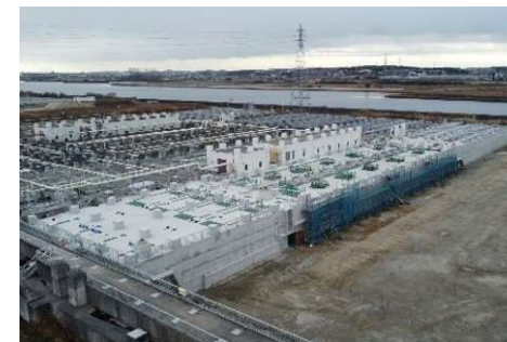
境川浄化センター (刈谷市) 処理場増設
