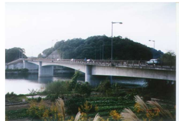
▲山室橋(豊田市)の耐震補強
