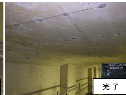
矢作川浄化センター 最初沈殿池の鉄筋補強
