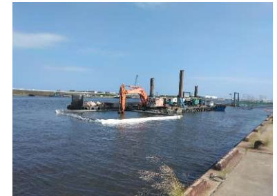
一色漁港 泊地浚渫 (西尾市)
