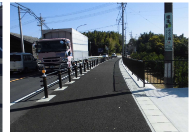
(主)東浦名古屋線 歩道設置
