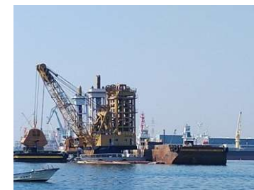
泊地浚渫状況写真
