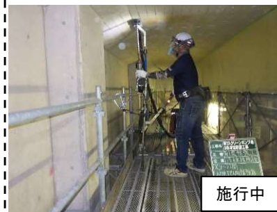
矢作川浄化センター 最初沈殿池の鉄筋補強
