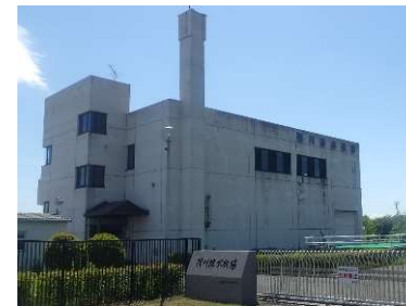
筏川第一排水機場(飛島村)
