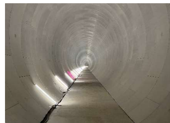
▲二級河川柳生川(豊橋市) 地下河川(トンネル坑内)の整備
