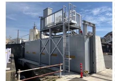
衣浦港高浜地区陸閘(高浜市)
