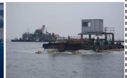
覆砂の作業状況
