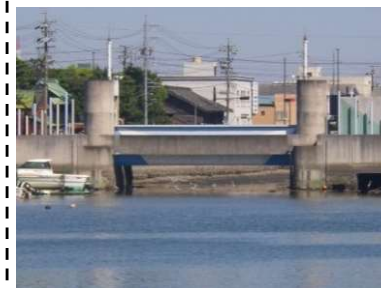
大浜漁港海岸水門(碧南市)
