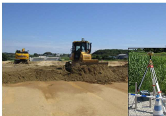
▲ICT建設機械による施工
