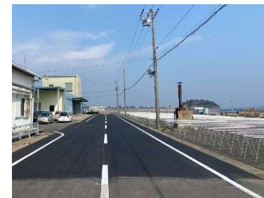
篠島漁港 舗装補修 (南知多町)
