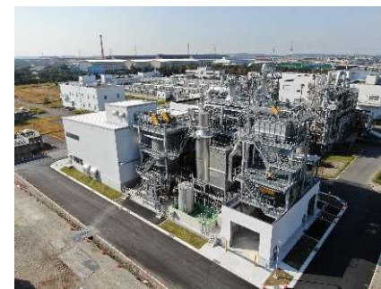
衣浦西部浄化センター 共同汚泥処理施設 (半田市)
