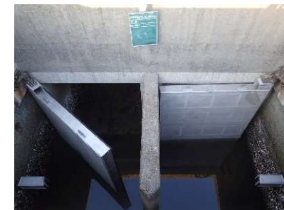
硯防潮樋門(蒲郡市)
