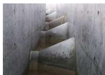
D写真 魚道内部の越流堰
