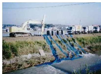
応急ポンプによる排水の様子 (2000年9月東海豪雨)
