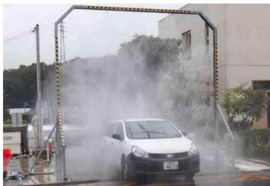
家畜伝染病防止のため畜舎入口に設置された車両消毒装置
