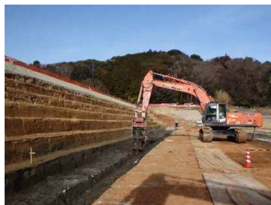
地盤改良によるため池の耐震対策
