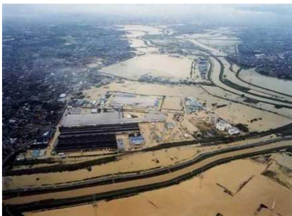
豪雨による農地の被災状況
