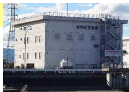
ゼロメートル地帯の排水機場に設置された緊急避難用の階段
