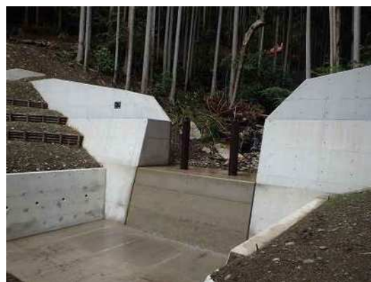
豪雨等による倒木の流出防止機能を有する治山ダム
