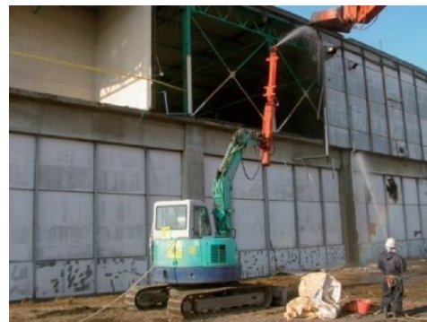
湿潤化の例(散水)
