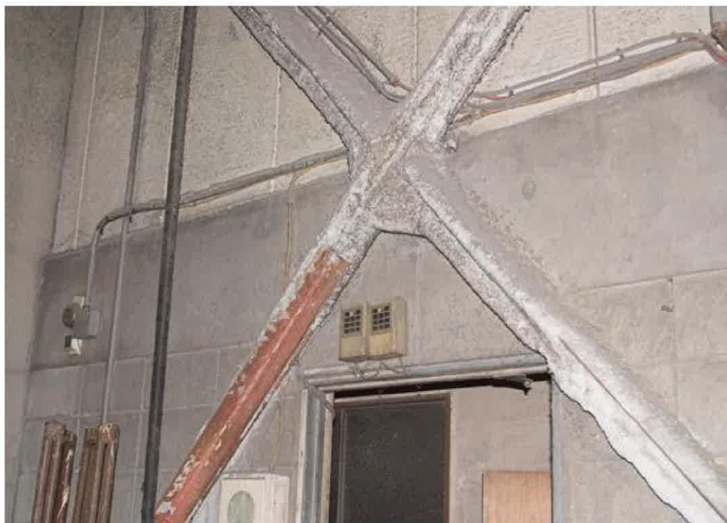
吹付け耐火被覆
