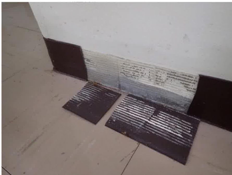
巾木（壁のクロスと接着材も除去）
