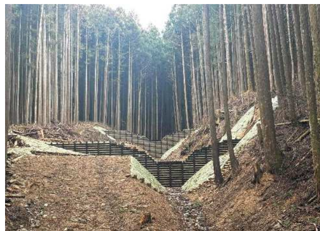
木製床固工（設楽町）
