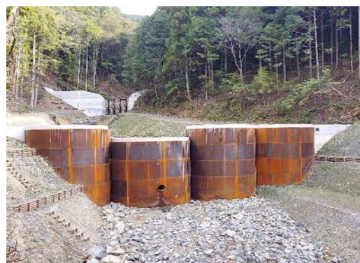
鋼製セル谷止工(新城市)
