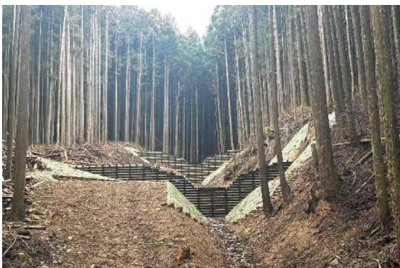
木製床固工(設楽町)
