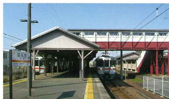
半田駅ホーム(高架工事着手前)
