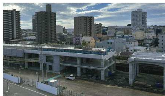
高架工事状況(2025年10月)
