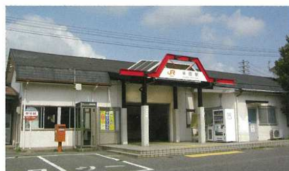
半田駅(高架工事着手前)
