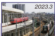
名本線豊橋方面高架切替
