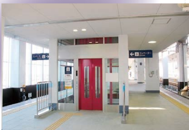
駅に設置されたエレベーター
