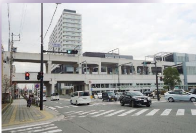
踏切が除却された道路
