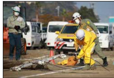
電力・通信会社による電線安全確認
