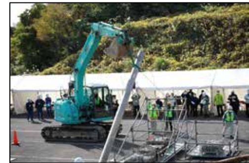
建設業者による倒壊電柱の撤去
