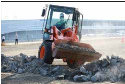
重機によるがれき撤去
